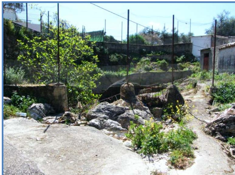
El planteamiento que se propone es el de elaborar un muro de unos 80 cm de altura, conservando la verja que existe en la parte derecha de la imagen (que no se aprecia en la misma) y colocar una alambrada a partir del muro. De esta forma se evitaría la falta de seguridad que se describía al principio.
