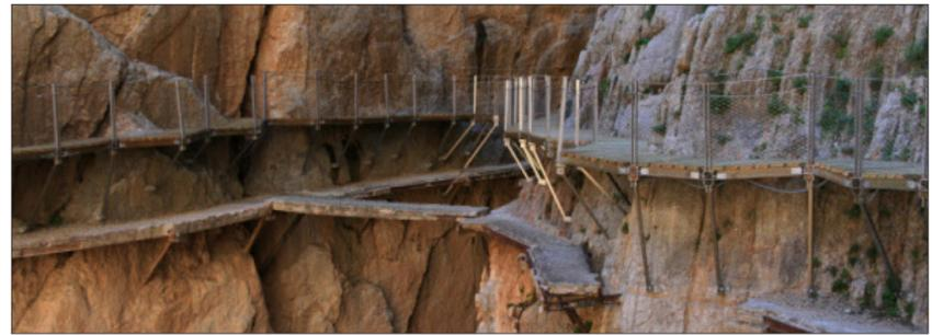
Alt versus neu: An einigen Stellen des Weges ist die alte Variante noch präsent. Heute gut gesichert, hatte der „Caminito del Rey“ von einst nicht mal mehr ein Geländer. Die verfallenen Betonplatten sind an vielen Stellen von Löchern durchzogen, streckenweise sogar ganz abgebrochen.
