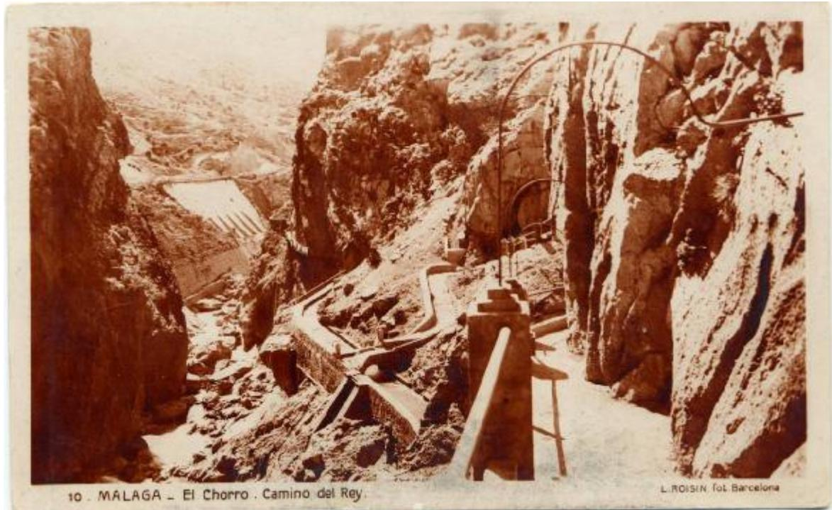
Primer tramo del canal. En primer término los balconillos que conforman el Caminito del Rey. Al fondo el canal sobre el que pasa el camino. En la ladera de enfrente, el ferrocarril Imagen: C. Pedro Cantalejo
