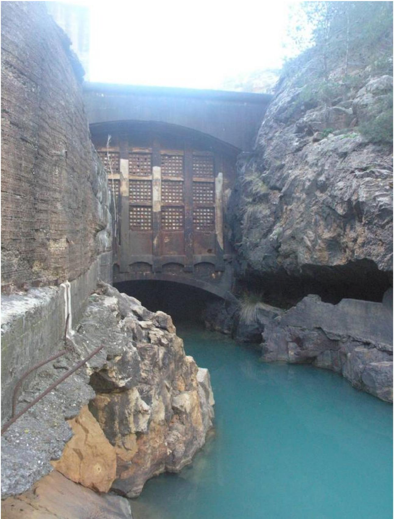
Estado actual de la cristalera de pavés del muro de aguas abajo de la presa y central de Gaitanejo. Imagen: I. B.
