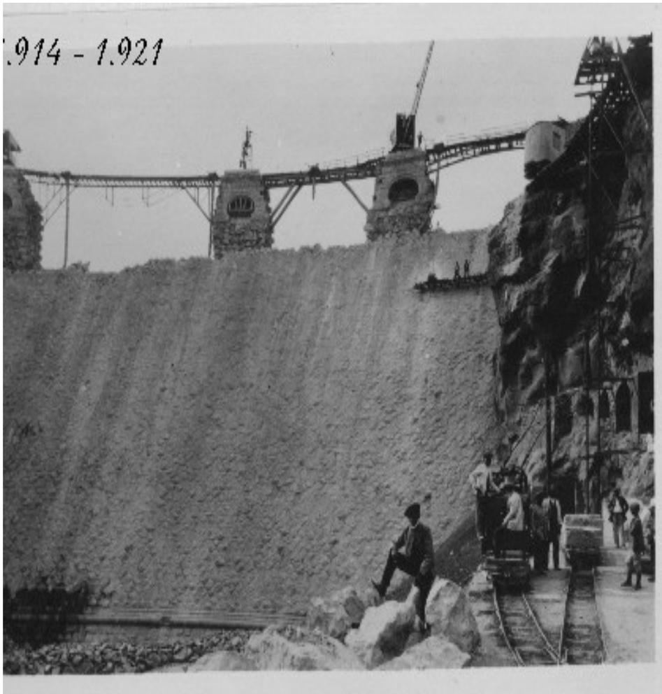
Periodo de construcción de la presa del Chorro. Pueden verse los pilares embebidos en la mampostería para sostén de las grúas. Foto: CHS
