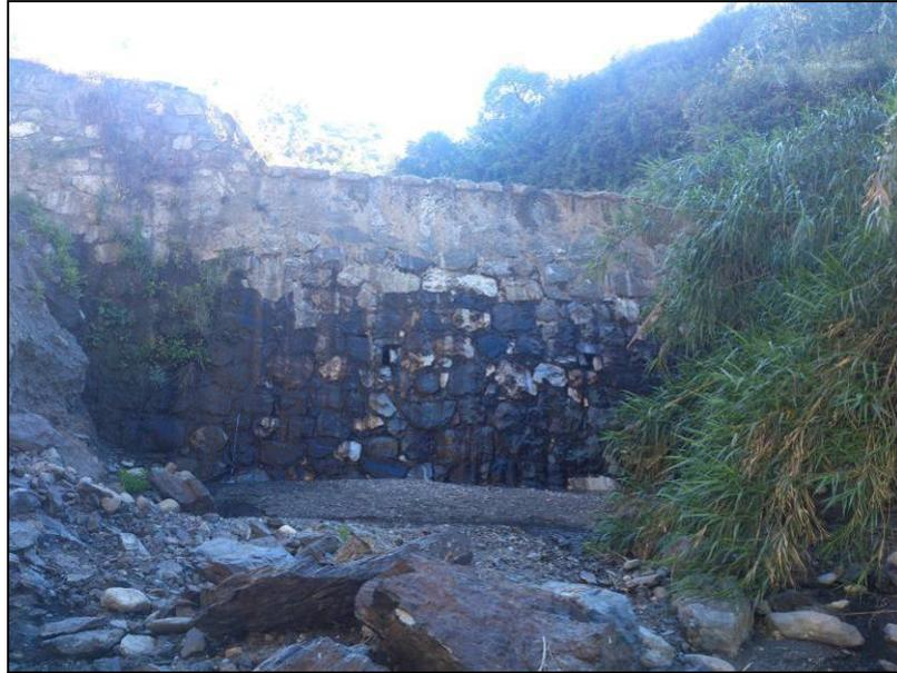
Fotografía 53: Dique de contención en el tramo medio del río Almanchar.
