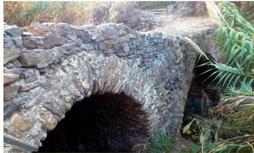
Detalles constructivos del Puente de las Ánimas, con sus dos ojos y los arcos de mampostería y mortero
