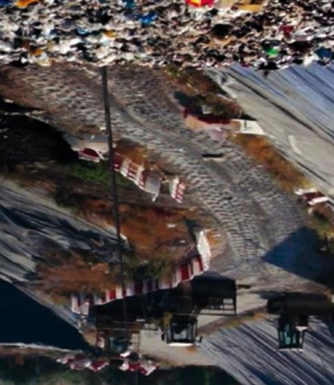
Le réseau de drains de surface de cette décharge était déficiente dans certains domaines, tels que le manque de caniveaux dans certaines sections, le manque d'entretien des fossés et l'aménagement de drainage inadéquat ou pauvres dans des domaines spécifiques. Et des mesures de confinement dans les zones de glissement de terrain liées aux écoulements lixiviat ont été nécessaires.
